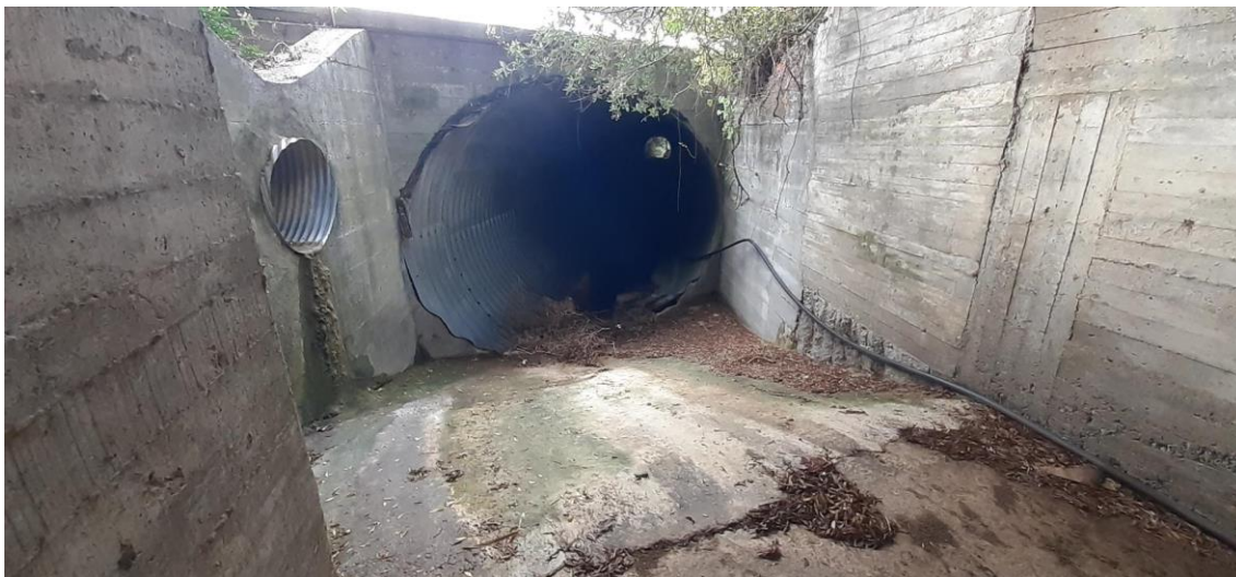
Aspecto de la zona de aguas debajo de la ODT-1A, y entrada de la ODT-1B
