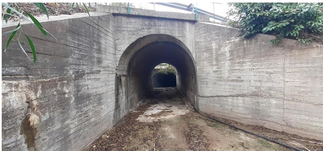
Aspecto de la zona de aguas arriba de la ODT-1A
