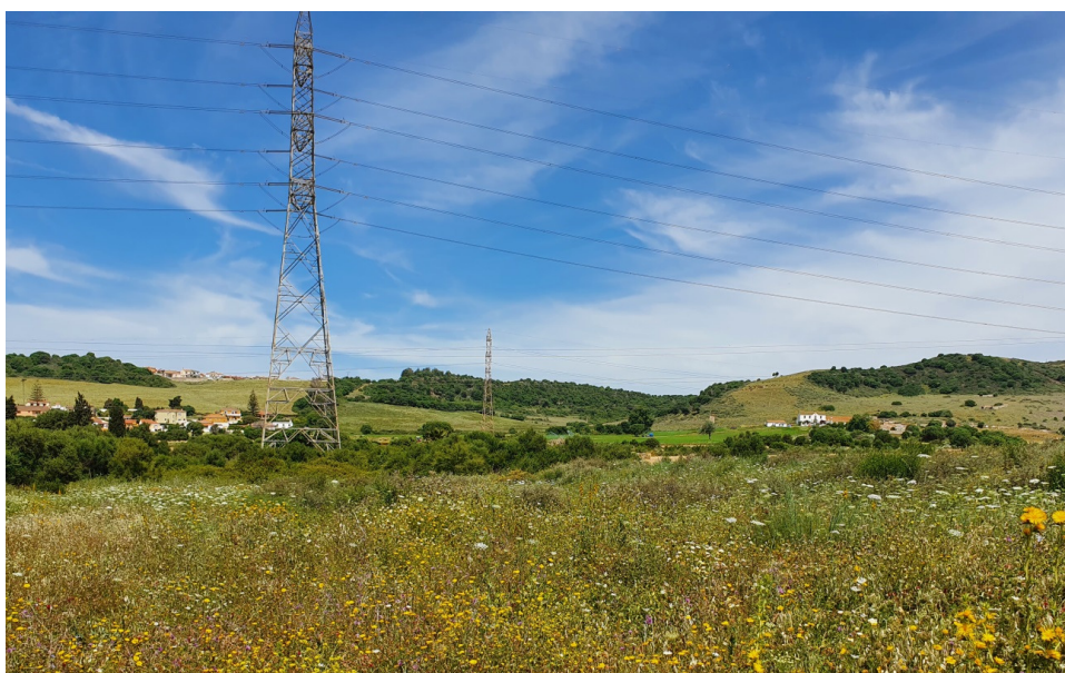
Imagen nº 14. Torre eléctrica situada en el exterior de la parcela.
