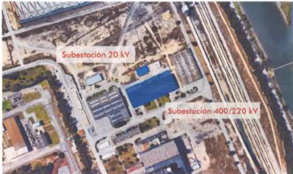
Subestaciones eléctricas de EDE y REE. Elaboración propia.
