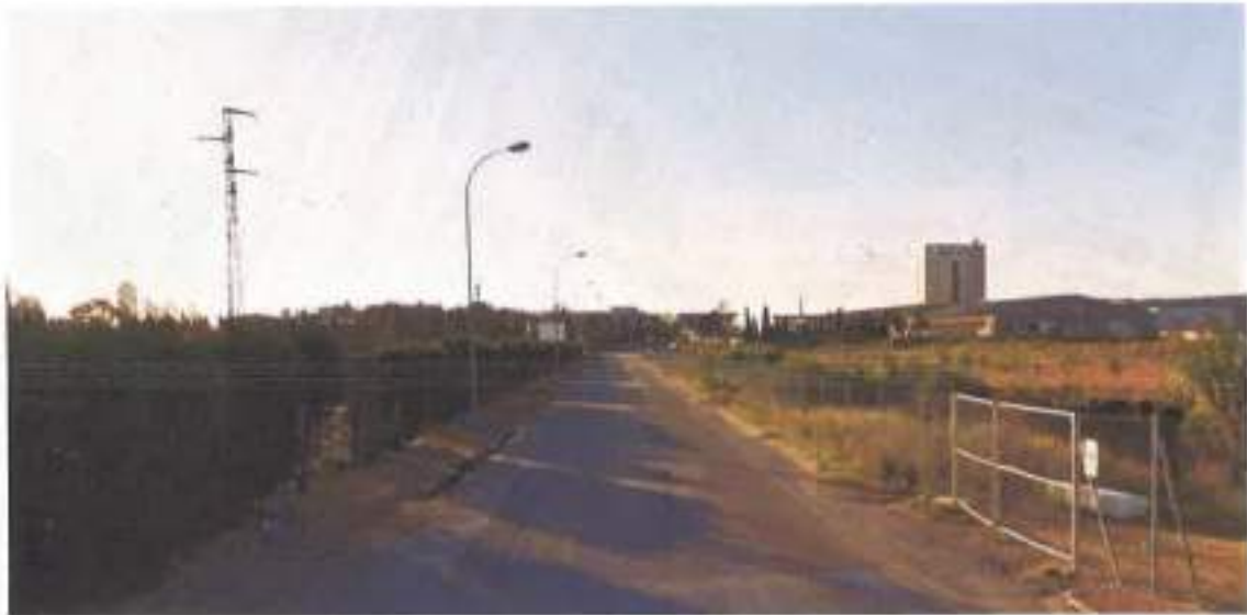
Vista del estado de urbanización del viario municipal de acceso.
