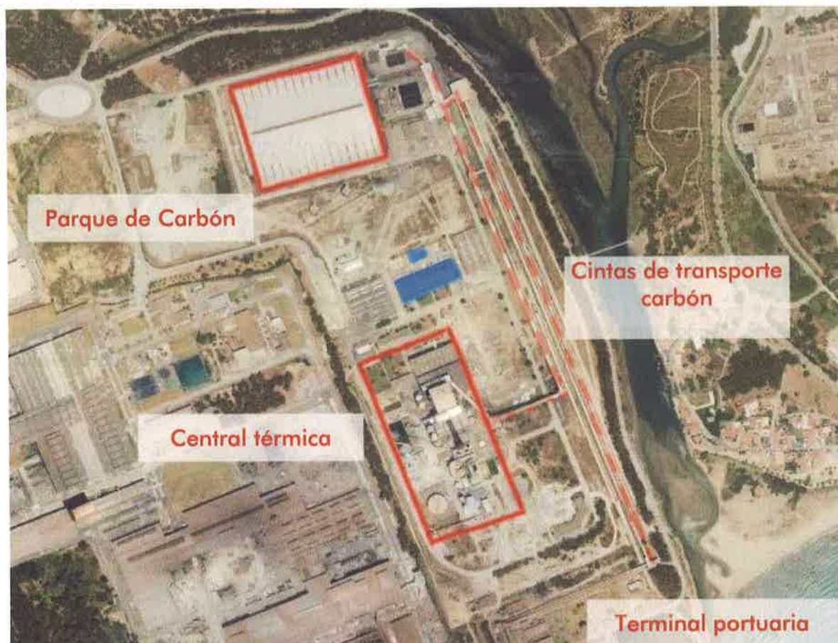
Instalaciones principales de la parcela de la central térmica. Elaboración propia.
