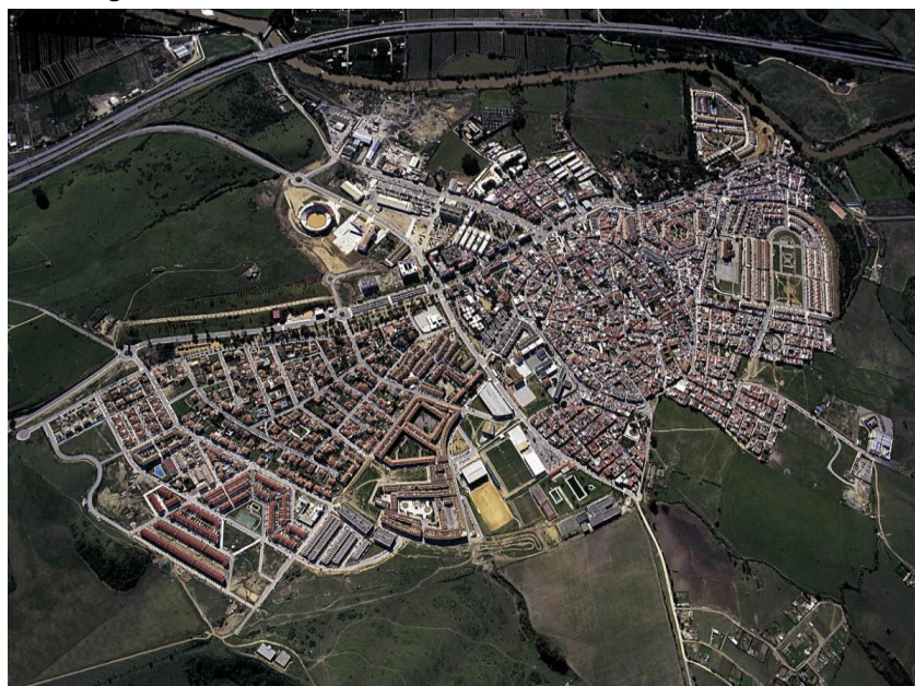
Figura 54. Núcleo urbano de la Villa de los Barrios
